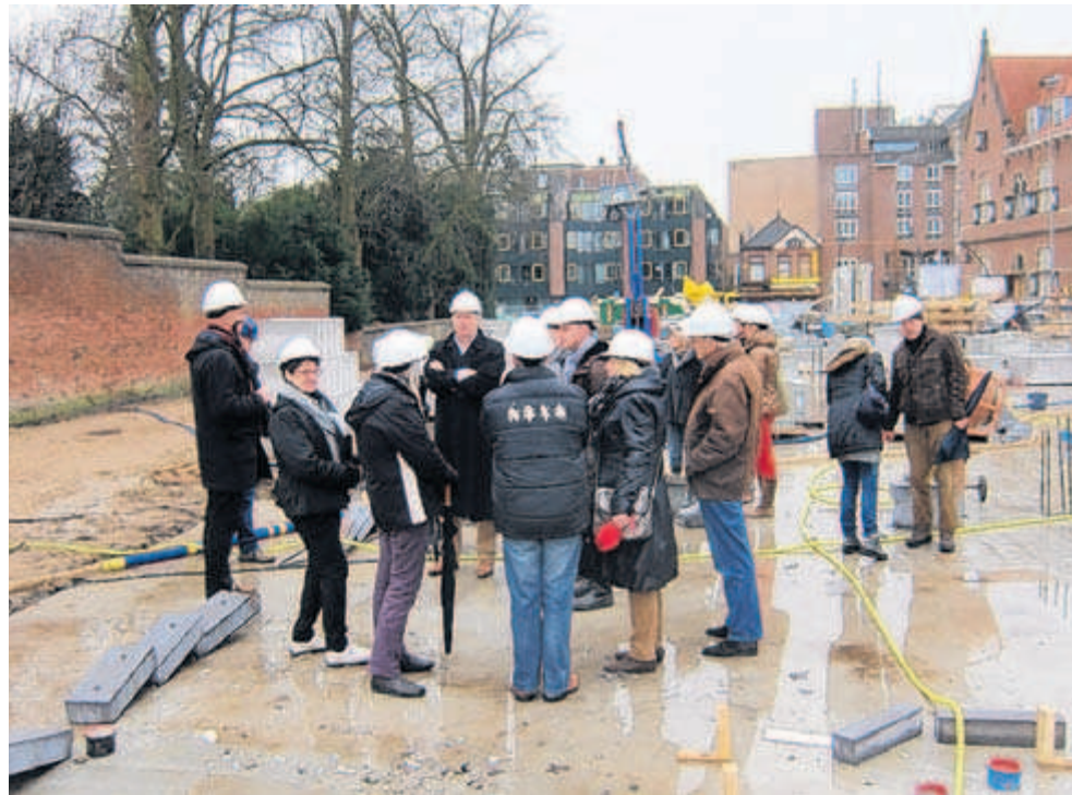
Een kleine 20 belangstellenden konden zaterdagmiddag op de bouwplaats van het gemeentehuis en de appartementen daarachter sfeer proeven. De eerste muren staan al bijna!
